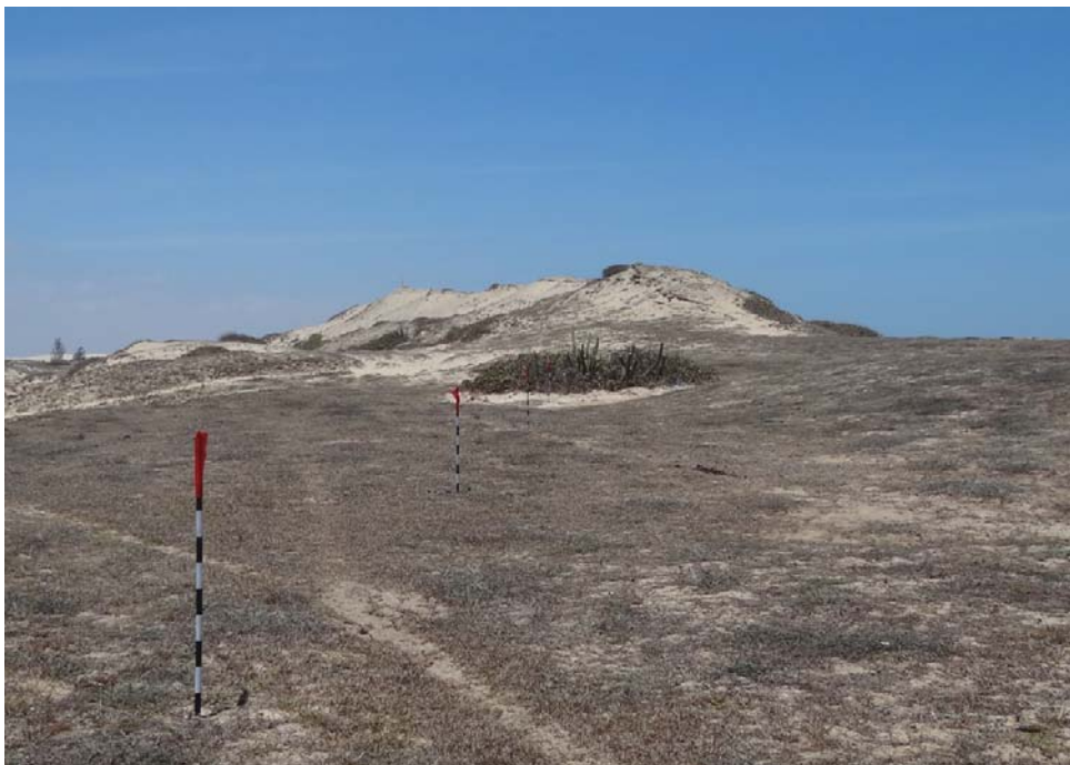
Figura 7 - Alinhamento de cortes demarcados no terreno. Ao fundo, dunas fixas com formação de eolianitos.
