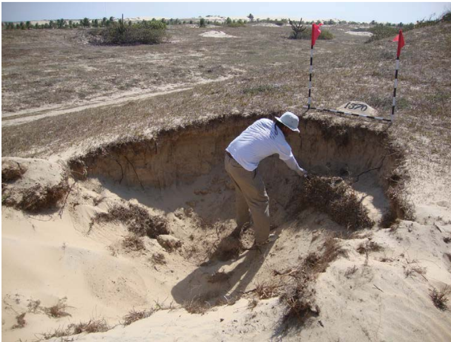
Figura 14 - A baixa consolidação do sedimento ocasionou diversos desabamentos.
